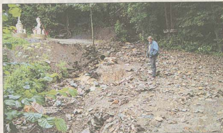
Schutt und Geröll beschädigten die Gemeindefstraße in Guttaring. Die Vulgo-Höfe Haselnusser und Eberhard blieben unversehrt, wurden jedoch von der Außenwelt abgeschnitten.
