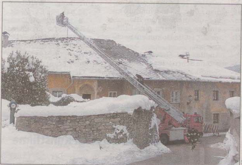
Die Freiwillige Feuerwehr Althofen befreite das Dach des Wohnhauses mit einem Wasserstrahl von der tonnenschweren Schneelast.
