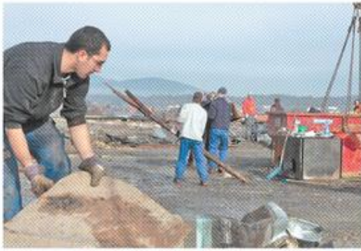
Am Dach des Hochhauses werden nach dem Brand die Überreste beseitigt
