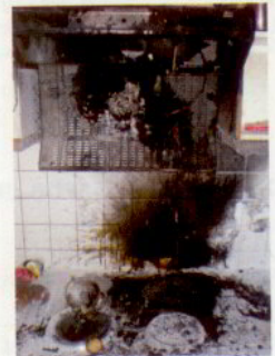
Die Brandursache ist noch unbekannt – im Bereich des Herdes gab es starke Brandeinwirkung
