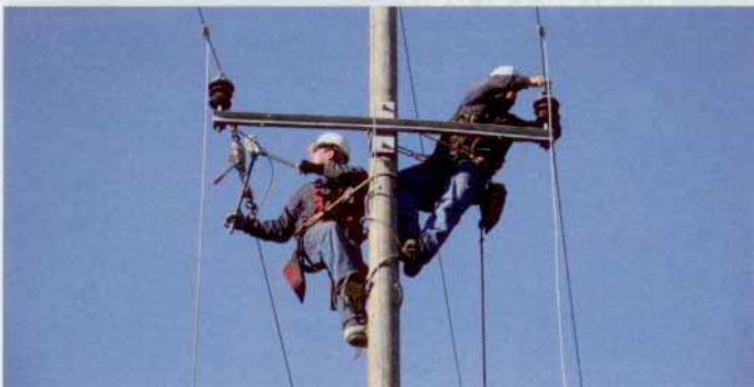
Sturmschäden: Kärntner Kelag-Monteur und Feuerwehren im Dauereinsatz
