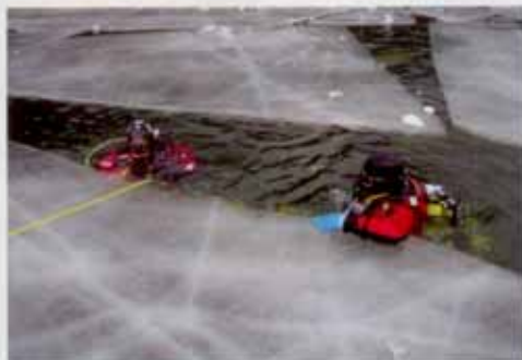
Im Uferbereich musste die Eisdecke zur Bergung der Arbeitsmaschine entfernt werden
