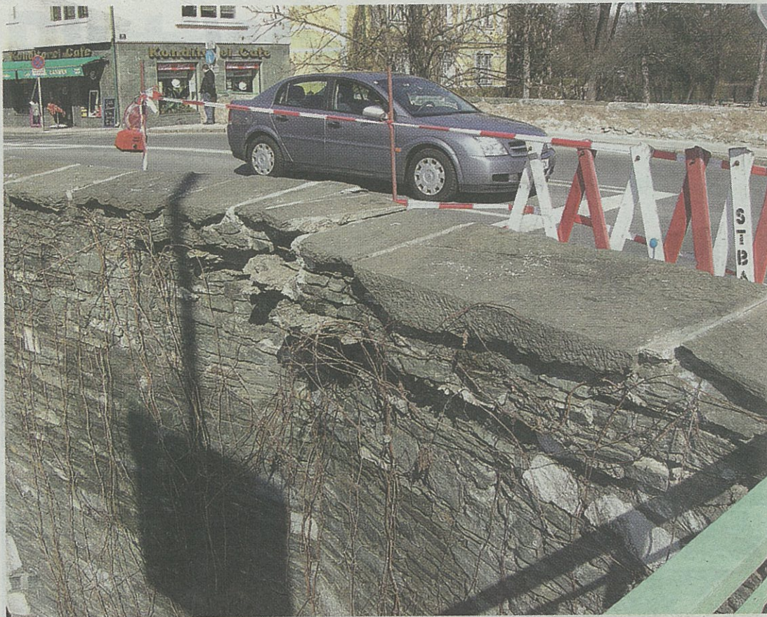
Wie ein Geschoss muss der Wagen in der Steinernen Brücke eingeschlagen haben. Teile der Mauer wurden verschoben und ragen jetzt über ihren Unterbau hinaus. Ein Scherengitter schützt den Bereich.
