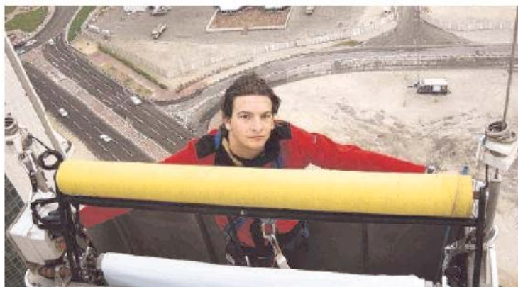
„Context“-Mitarbeiter Stefan Walcher arbeitet in schwindelerregender Höhe am Wolkenkratzer in Doha, wo er großflächige Folien anbrachte Context Media Group
