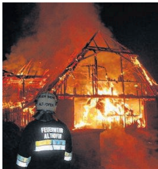
Das Stallgebäude in Kappel brannte völlig aus. Die angrenzenden Gebäude konnten gerettet werden
