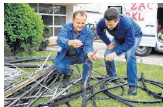
Reparaturarbeiten nach dem nächtlichen Brand
