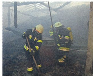
Verhindert wurde ein Brandübergreif auf Nachbarobjekte
