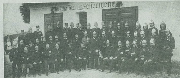
Die Althofener Wehr vor dem alten Rüsthaus
