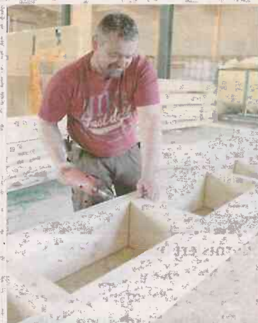
Bei der Arbeit: Hallenleiter Christian Dörflinger setzt Fertigteile zusammen
