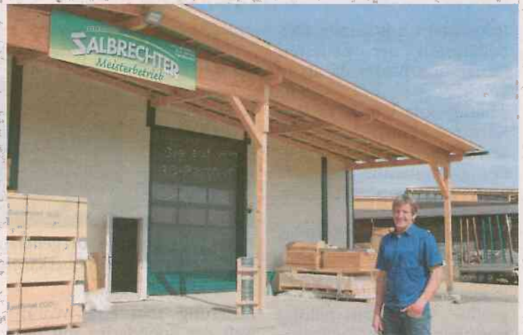
Neue Halle: Gerald Salbrechter vor der neu aufgebauten Halle, in der Fertighäuser produziert werden
