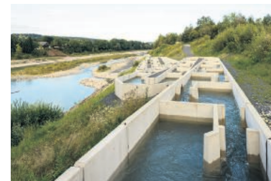
◆ Was aussieht wie ein Unterwasserlabyrinth ist die Fischwanderhilfe bei Rosegg WIEDL (2)
