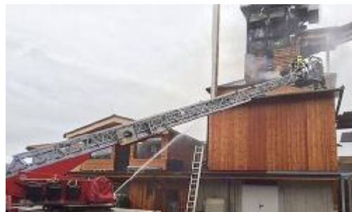
Brand in Hackschnitzelanlage: Explosion bei Löscharbeiten © KLZ
