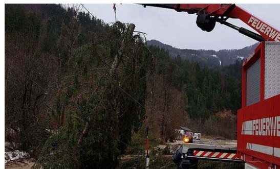
Wenn Bäume Leitungen kappen, kann die stromlose Zeit lange werden © BACHHIESL
